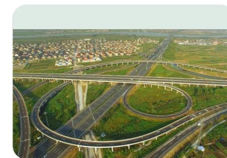
甬金高速绍兴段增（扩）建服务 （停车）区项目
